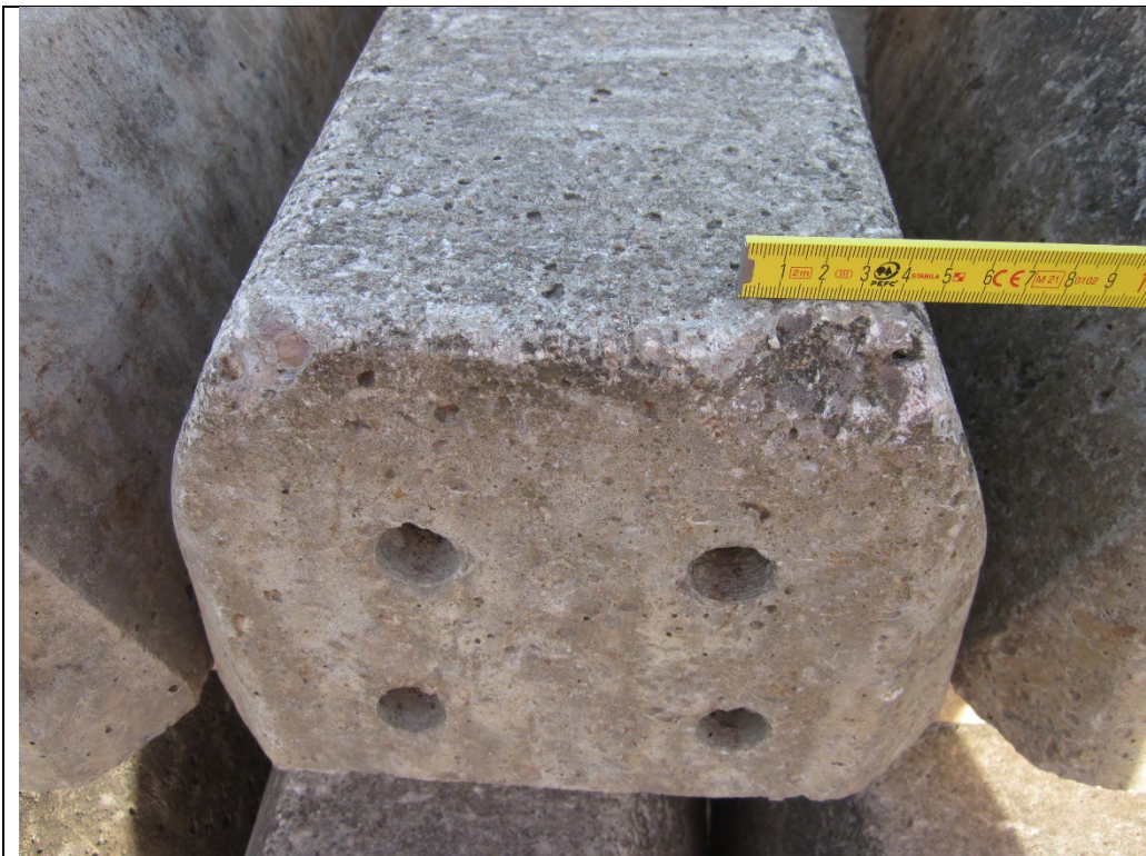
Abbildung 17: Beispiel zu Bereich 3 (Schwellenkopf): Ausbruch am Schwellenkopf, Breite kleiner als 6 cm und Tiefe geringer als 2 cm, somit zulässig .
