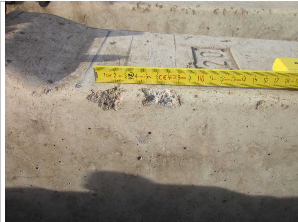
Abbildung 14: Beispiel zu Bereich 2: Zwei Abplatzungen im Mittelteil der Schwelle. Jeweils kleiner als 6 cm und damit zulässig.
