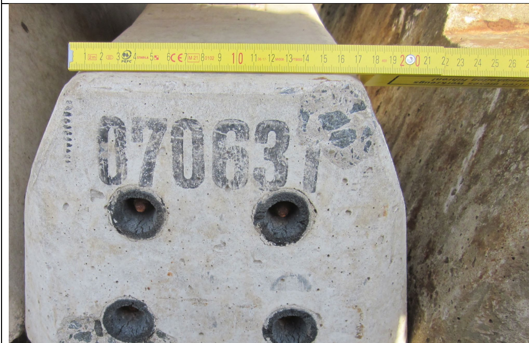
Abbildung 19: Beispiele zu Bereich 3: Abgeplatzte obere Ecke an der Schwelle, Breite kleiner als 6 cm und Tiefe geringer als 2 cm, somit zulässig.
