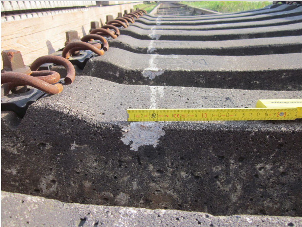
Abbildung 15: Beispiele zu Bereich 2 (übriger Schwellenkörper): Abplatzung und zugehöriger Abrieb, vermutlich verursacht durch Entlangfahren mit herabhängendem Gegenstand. Abplatzung kleiner als 6 cm und somit zulässig.
