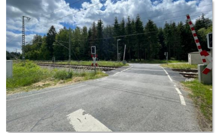
BÜ Kornbach km 137,1 (Strecke 6362)
