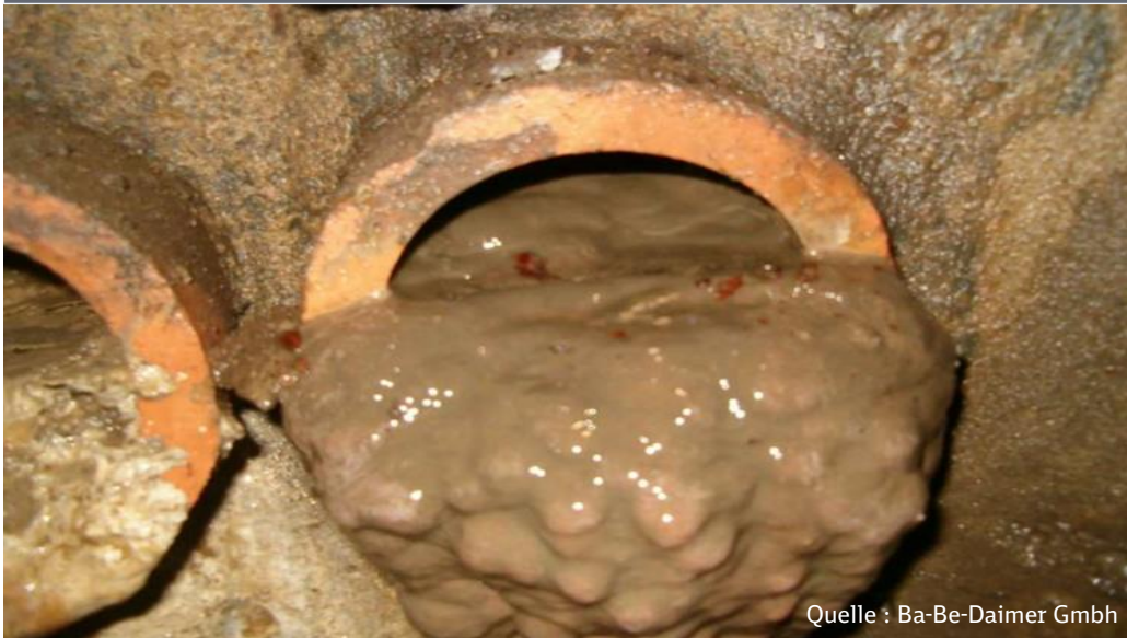
Verschlammtes Entwässerungsrohr
