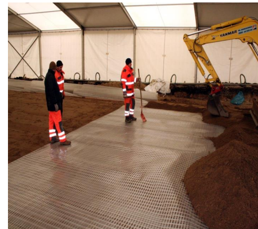
Tragschichtsystem mit Geogitter und Geovlies
